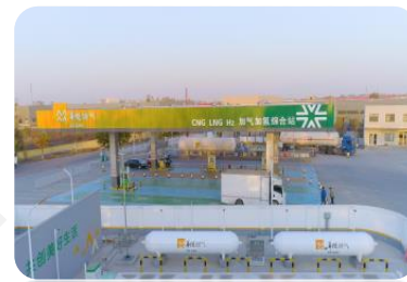
潍坊206国道加氢站
